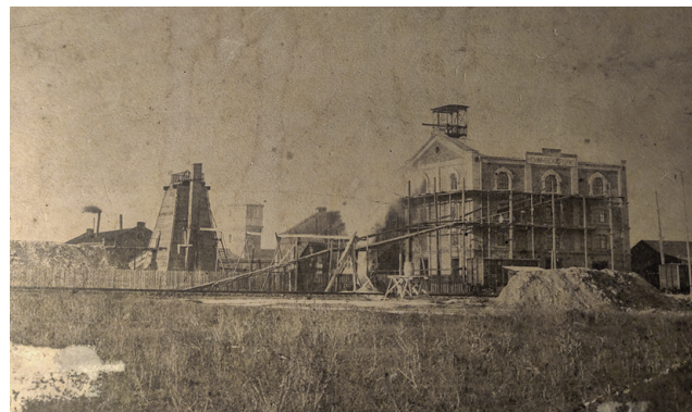
Будівництво Кузьминівського соляного рудника. Фото початку XX ст.
