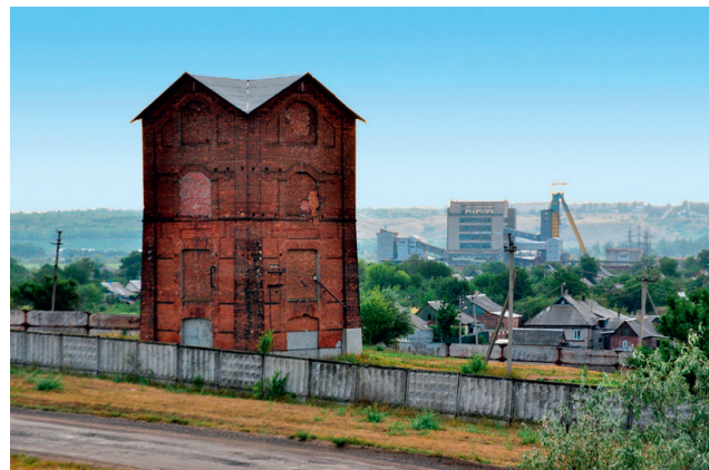
Водонапірна вежа. Фото Михайло Кулішов
