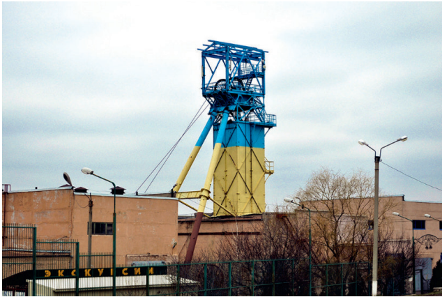
Вентиляційний ствол № 3-біс. Фото Михайло Кулішов
