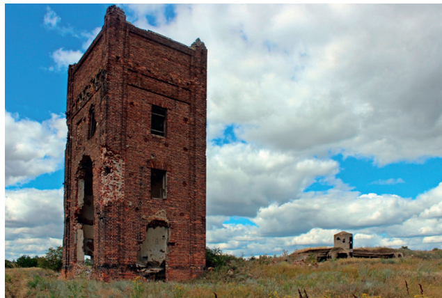
Лоскутівська станція перекачки розсолوپроводу «Донсода-Карфаген». Фото Микола Ломако
